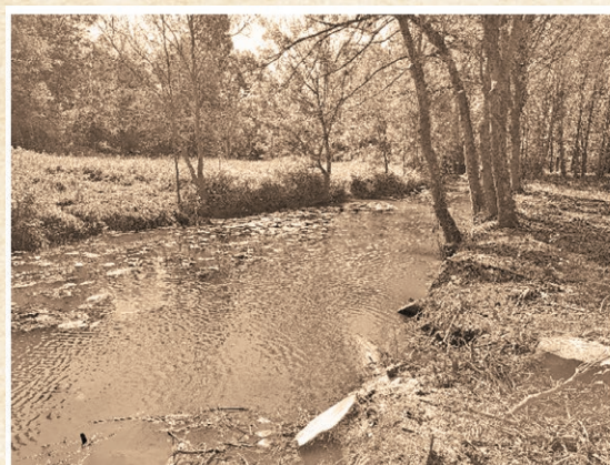
Comparatif avant/après : Réduction et empiérement du fond du lit de l'Echandon
