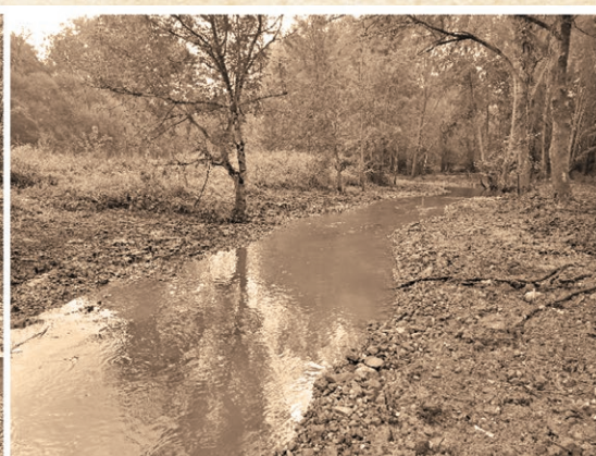
Comparatif avant/après : Réduction et empiérement du fond du lit de l'Echandon
